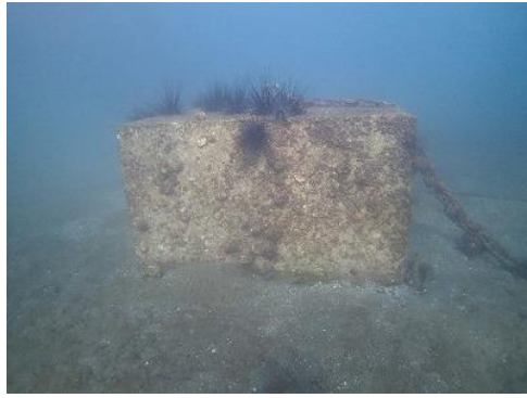
典型的な沈下状況(左:1番)10~30 cm 最も大きな沈下状況(右:23番)約80 cm
