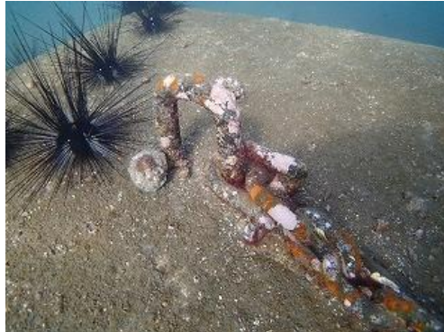
吊り筋とシャックルの接続状況
