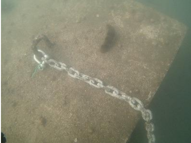
シンカーのU字金具に新チェーンを接続
